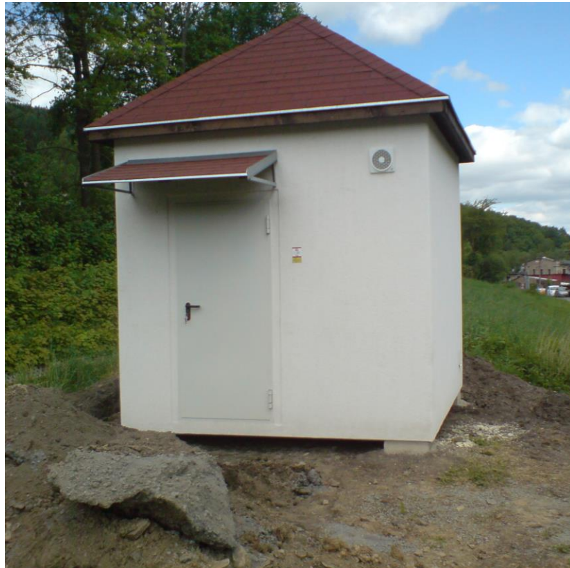
Obr. 2 Fotografie postaveného Technologického domku
