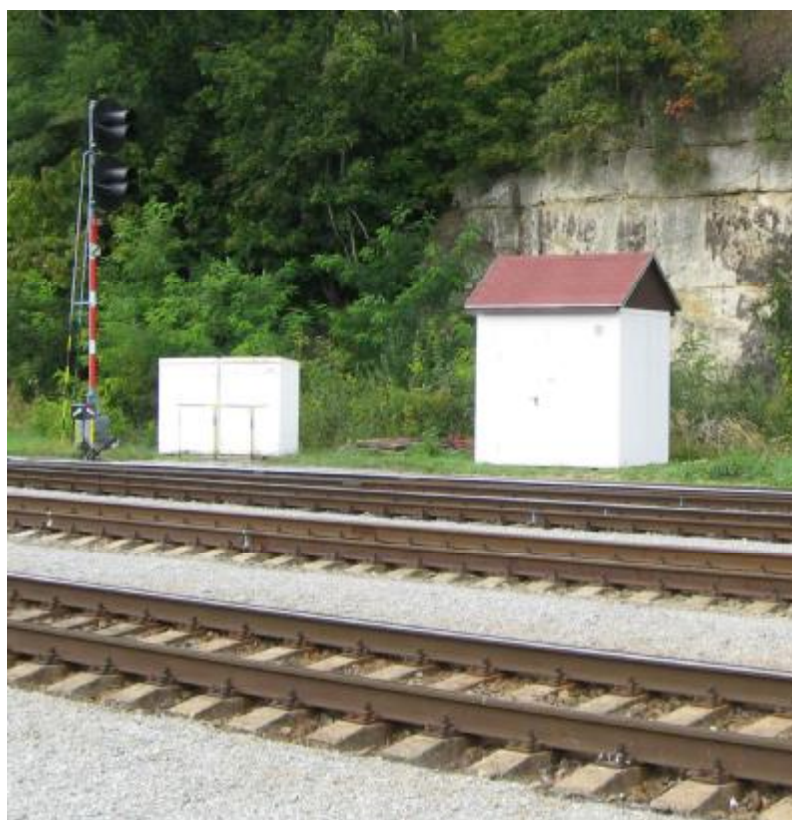
Obr. 2 Fotografie postaveného Technologického domku v žst. Bakov nad Jizerou
