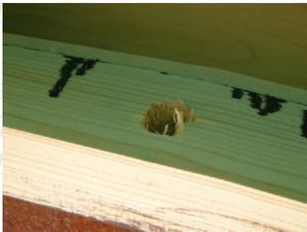
Obr. 5 Otvor v pozednici střechy
