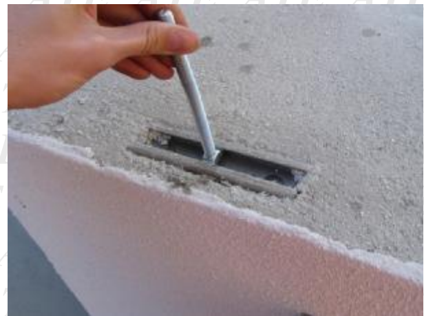
Obr. 8 Otočení šroubu o 90 °a zaklesnutí hlavy šroubu do profilu
