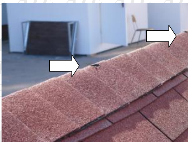
Obr. 1 Otvory ve střeše
