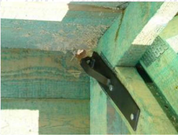
Obr. 3 Konzole pro zašroubování tyčí
