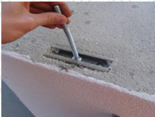
Obr. 7 Vsunutí hlavy šroubu do profilu
