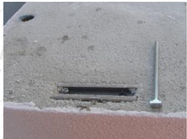
Obr. 6 Místo pro kotevní šroub na střeše dokmu a kotevní šroub
